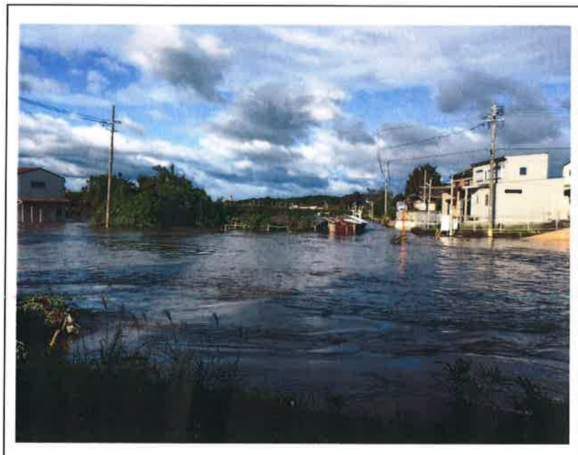
(H29 台風 21 号被害写真)
